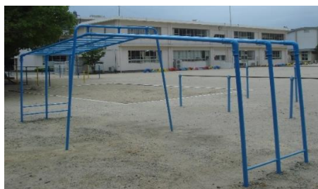
◎雲梯の改修（有川小学校）
