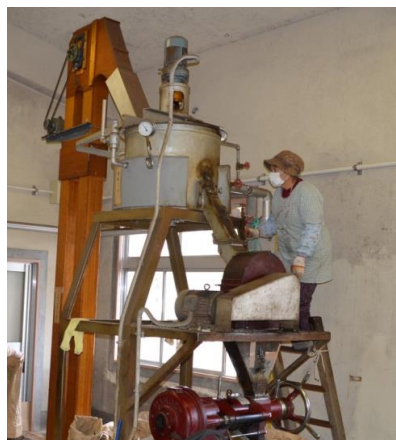
◎椿油加工場蒸気ボイラー
